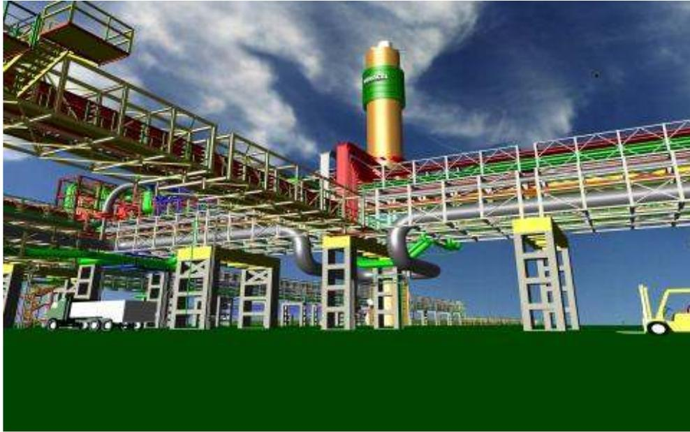
Fig. 5.1 Arreglo de un rack de interconexión de tuberías
