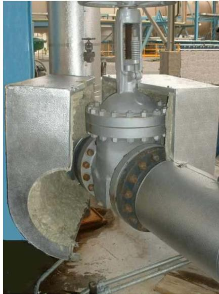
Fig. 5.3 Aislamiento para una válvula
